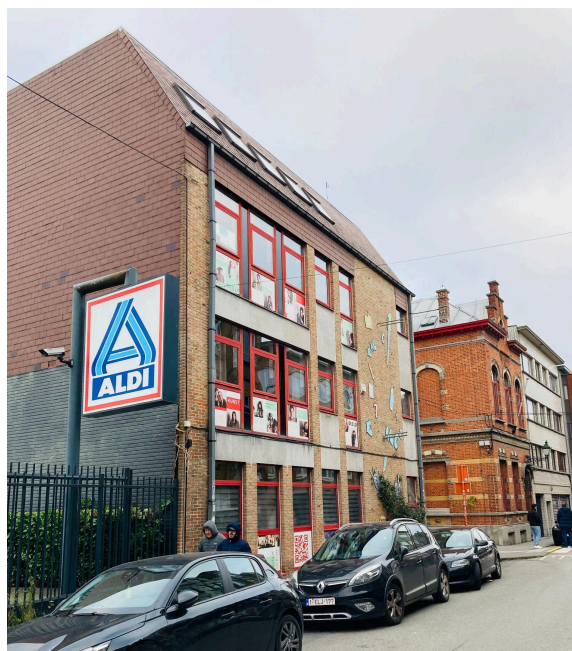
Gevels gebouw A en blok B, Sint-Guidostraat nr. 73
